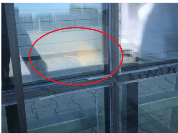
32 pav. PVB plėvelės išsilaminavimas dėl cheminio nesuderinamumo
