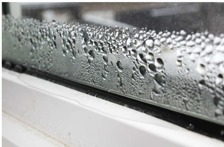
27 pav. Drėgmės kondensacija ant stiklo paketo išorinio stiklo
