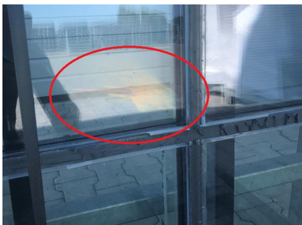
33 pav. PVB plėvelės išsilaminavimas dėl cheminio nesuderinamumo
