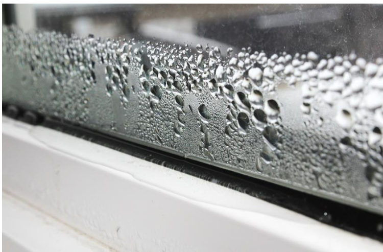
28 pav. Drėgmės kondensacija ant stiklo paketo išorinio stiklo
