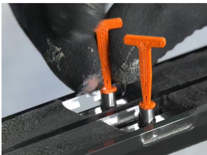
11 pav. SWS AIR montavimas į stiklo paketą
