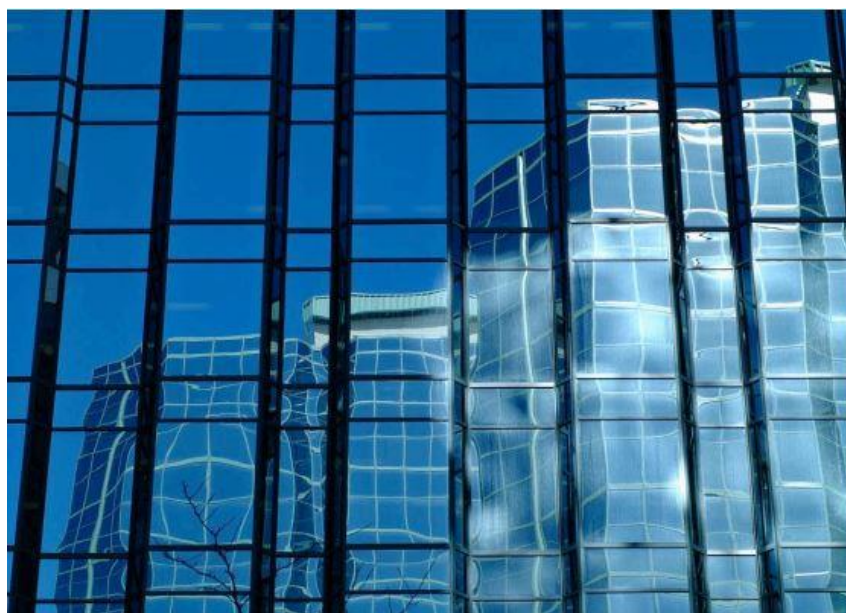
27 pav. „Bangavimo“ efektas, priklausomai nuo stiklų įsigaubimo/išsigaubimo, grūdintų stiklų bendro ir vietinio išlinko ir kt.
