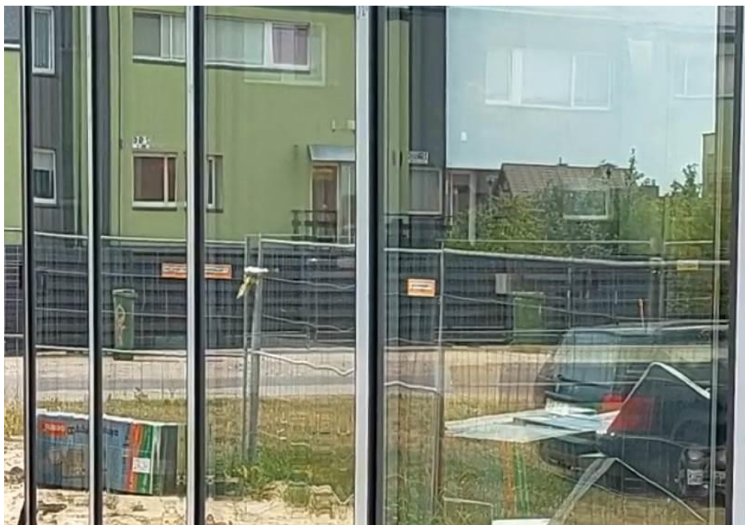
3 pav. Priklausomai nuo bendro ir vietinio išlinkio galimas neženklus „bangavimo“ efektas, kuris neiškrepia vaizdo stiklo pagrindinėje zonoje žvelgiant statmenai pro stiklą
