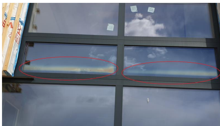
34 pav. Cheminis garavimas stiklo paketo viduje, viršijus rekomenduojamą 60 °C temperatūrą
