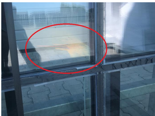
35 pav. PVB plėvelės išsilaminavimas dėl cheminio nesuderinamumo
