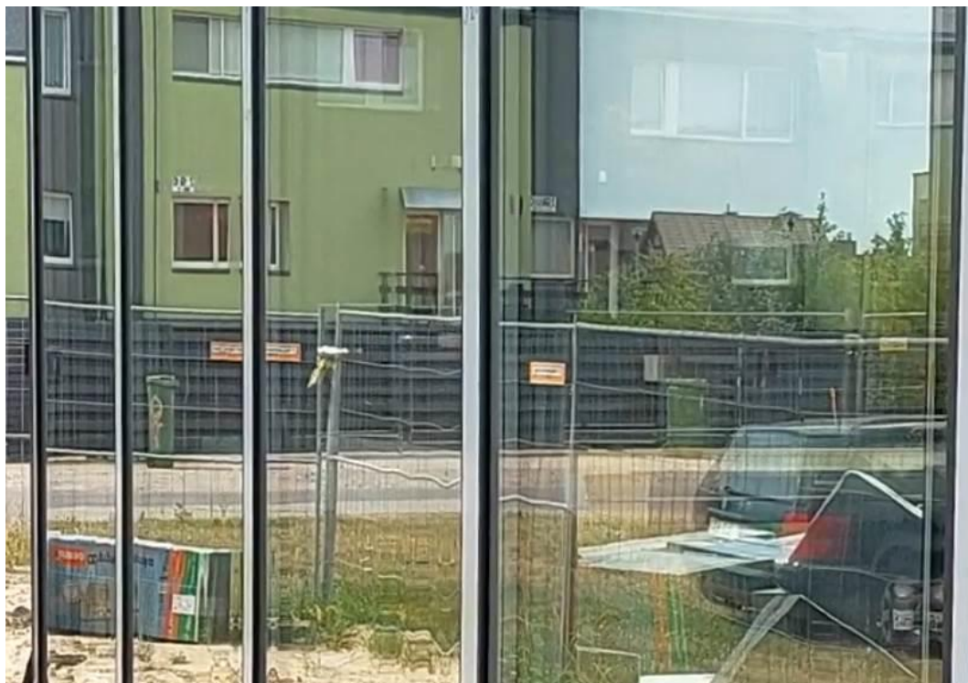
5 pav. Priklausomai nuo bendro ir vietinio išlinkio galimas neženklus „bangavimo“ efektas, kuris neiškreipia vaizdo stiklo pagrindinėje zonoje žvelgiant statmenai pro stiklą
